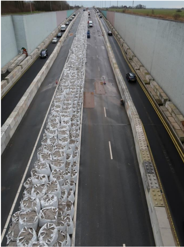
Figuur 3.7 Situatie ten tijde van het onderzoek – toerit zuid (gezien in zuidelijke richting).
